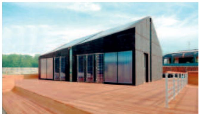
**Hoch wärmegeämter Kubus:** Das Haus der Bergischen Universität Wuppertal kombiniert Bauteile im Passivhausstandard mit solar aktiven Flächen (oben und links).
