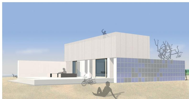
Solarwand mit Modulen unterschiedlicher Zelltypen
