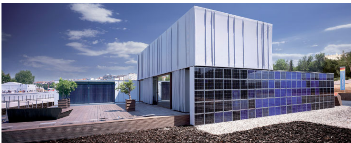
Bild 2. Das Gebäude der Universität Wuppertal zum Solar Decathlon 2010 in Madrid; die Energieversorgung basiert auf Solarstromanlagen und Vakuumröhrenkollektoren in Verbindung mit einer Wärmepumpe (Foto: Peter Keil, Düsseldorf) Fig. 2. The building of Wuppertal University for the Solar Decathlon Madrid, 2010; the energy supply is based on solar power generation and vacuum tube collectors combined with a heat pump (Photo: Peter Keil, Düsseldorf)
