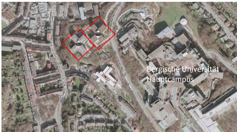
Bild 1 Luftaufnahme der beiden sanierten Gebäude. Auf dem Bild ist der Kreuztypus der beiden Gebäude, sowie die Lage unmittelbar am Fuß des Hauptcampus der Bergischen Universität Wuppertal zu erkennen. Bild: Google Earth
