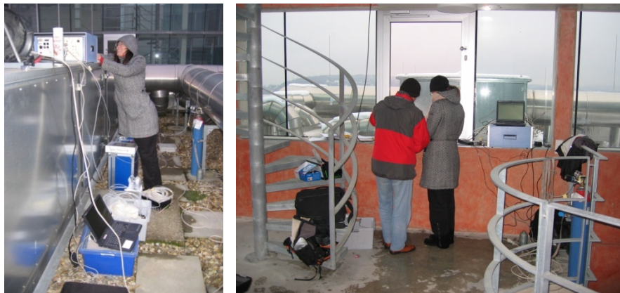
Bild 16 Tracergasmessung einer Lüftungsanlage auf dem Dach des Flügels 7 (PH). Durch Eintrag eines Indikatorgas und anschließender Messung der Gaskonzentration in allen Luftströmen können Aussagen über Luftleckagen in der Anlage gemacht werden. Die Lüftungsanlagen erwiesen sich in der Messung als hinreichend dicht. Bild: b+tga
