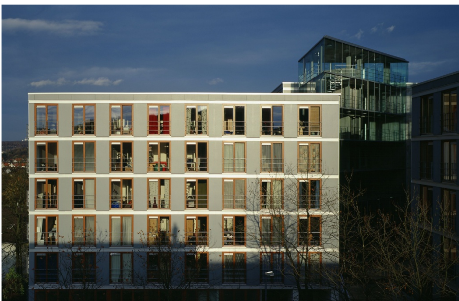
Bild 72 Ansicht der Hauptfassade eines Flügels des NEH. Durch die raumhohen Fenster beträgt der Fensteranteil an der Fassade 54%.
